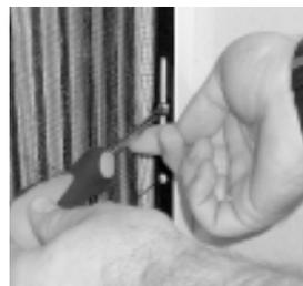
**G** Completare con l'inserimento ad incastro del magnete (4) nel profilo di chiusura (5a).
